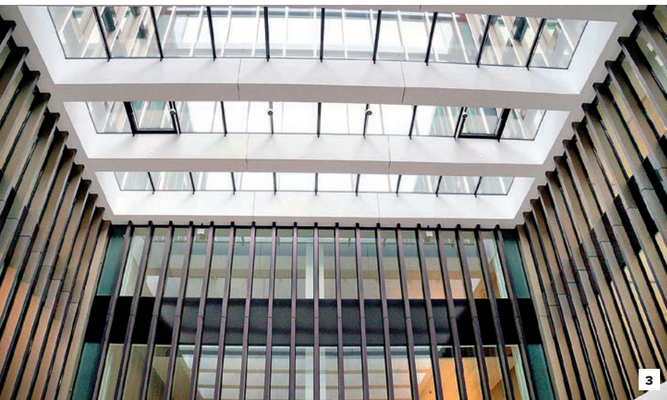
3 Atrium mit Dachverglasung
