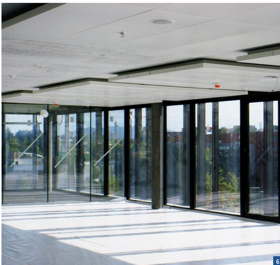
mussten aus statischen Gründen die Hohlkammern der Vertikalprofile mit eingeschobenen CNS-Flachprofilen verstärkt werden.
