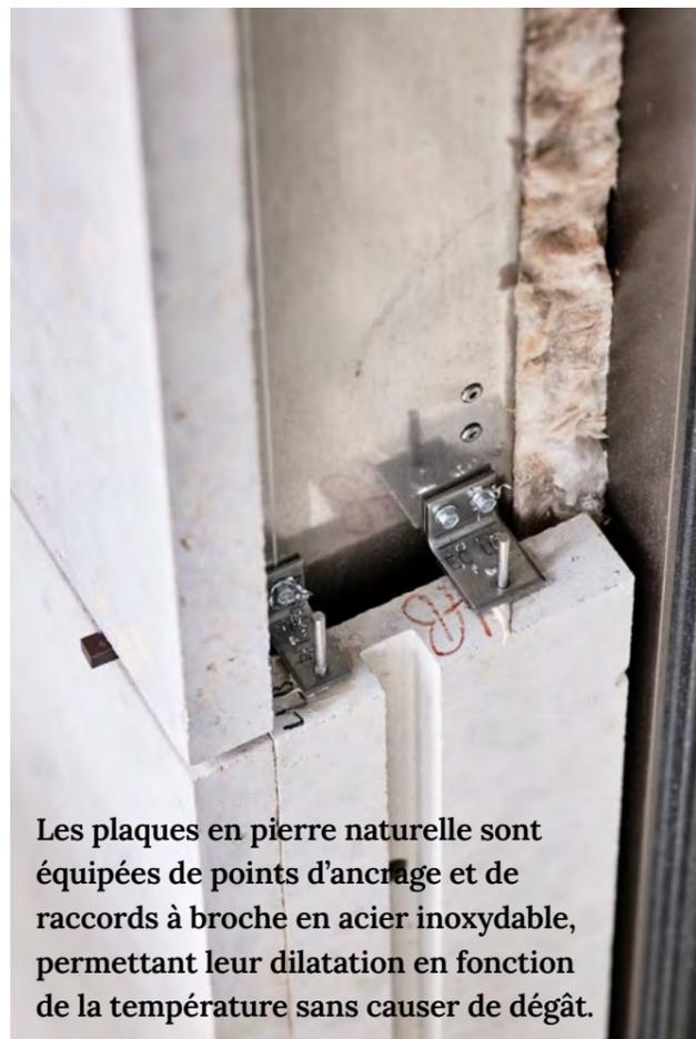
Les plaques en pierre naturelle sont équipées de points d'ancrage et de raccords à broche en acier inoxydable, permettant leur dilatation en fonction de la température sans causer de dégât.
