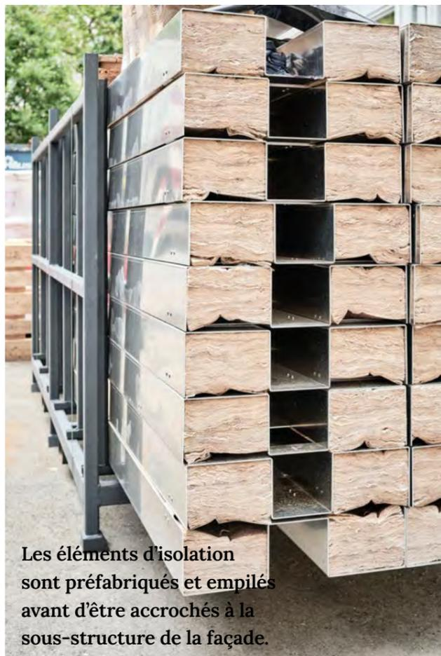
Les éléments d'isolation sont préfabriqués et empilés avant d'être accrochés à la sous-structure de la façade.
